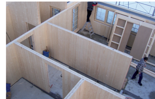
TWOODS-Elemente im Rohbau le gros œuvre avec des éléments TWOODS TWOODS-elements under construction
