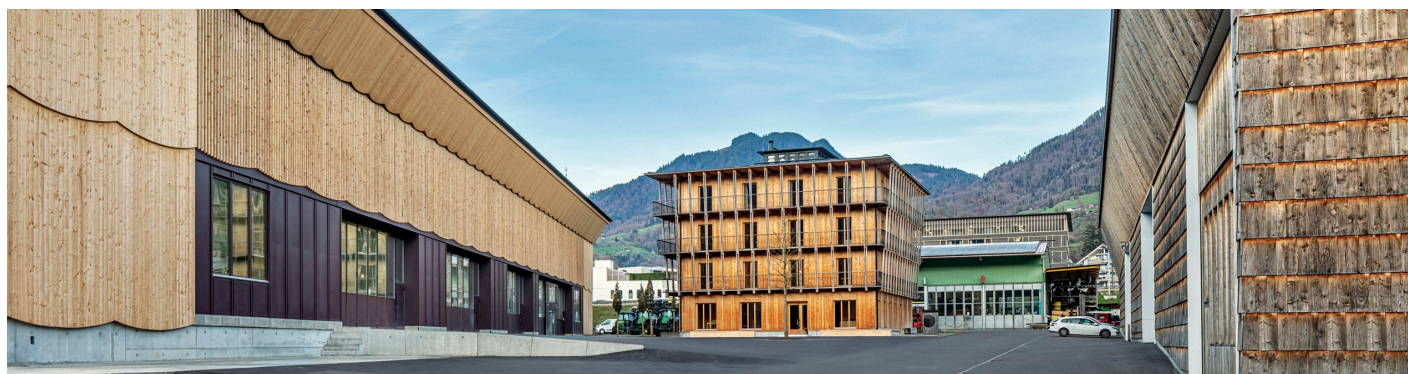
Holzbau aus Passion: KÜNG HOLZBAU in Alpnach Dorf.
