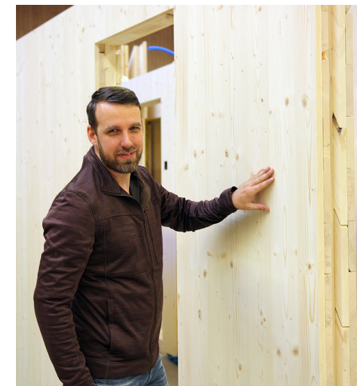
Die leimfreien Holzpur-Wandelemente werden aus Brettern im Kreuzverbund hergestellt und die Oberflächen entsprechend bearbeitet.
