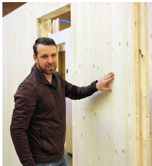
Les éléments de parois sans colle Holzpur sont fabriqués à partir de planches à joints croisés, avec des finitions en conséquence.
