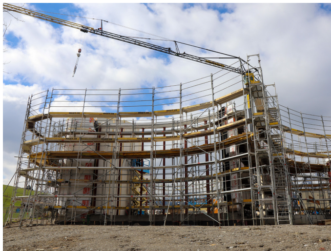
Baufortschritt in den vergangenen Monaten,
