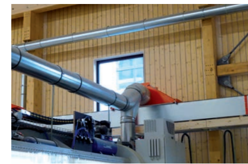
Schwebestaubentsorgung über Kanal aspiration micropoussières par canaux suspended dust disposal via duct
