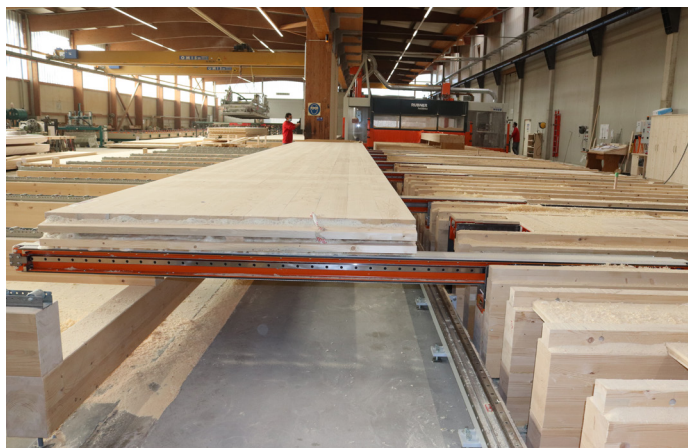
Éléments BSP arrivant directement de la fabrication sur la ligne de fabrication très compacte.
