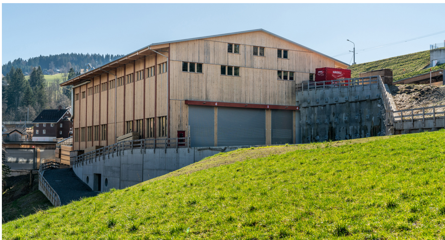
Die neue Werkhalle der Firma Nägeli AG im Speicher.
