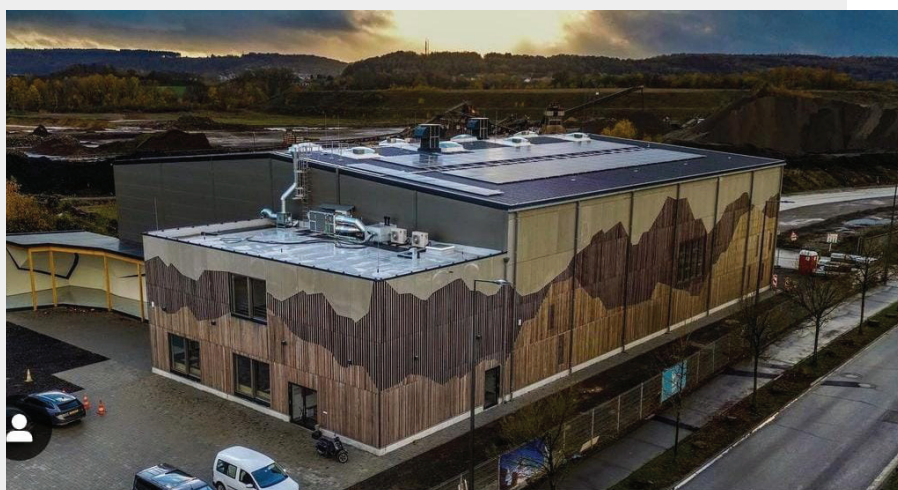
BlocX, salle de bloc à 4024 Esch-sur-Alzette, Luxembourg
